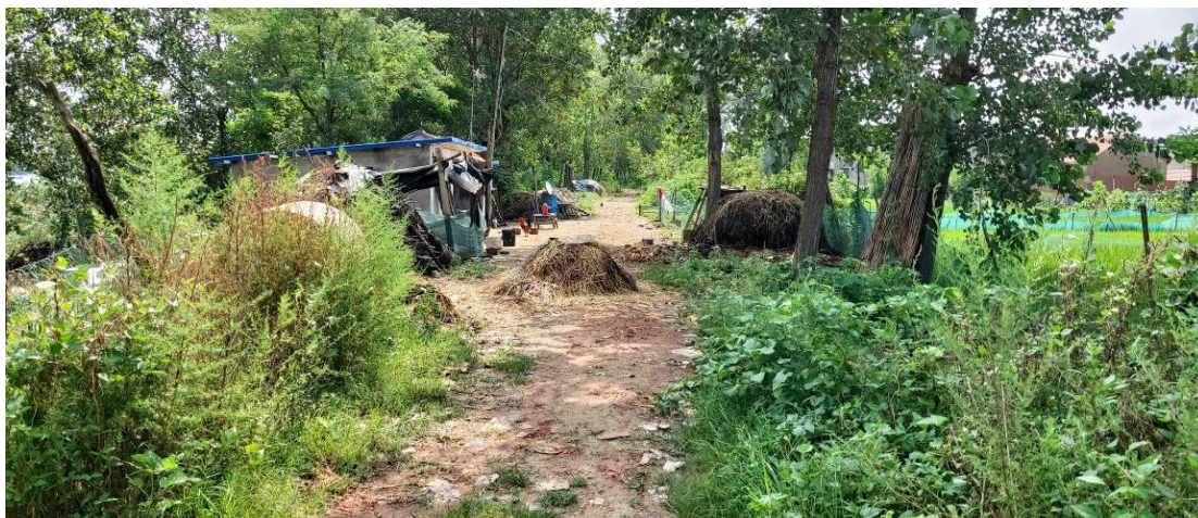
照片 1 打雁刘圩堤顶防汛通道不通畅、局部堤顶被侵占
